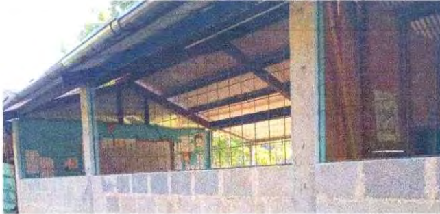
Foto 1: Sustitución de electromalla por ventanales formales
