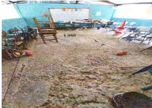
Foto 3: Área frontal específica para situar el piso, Aula 3 con un Total de 45 mts2
