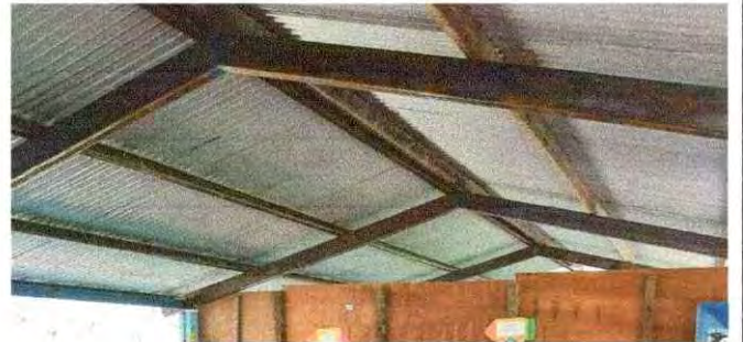
Foto 4: Estructura de techo actual para remozar, Aula 3 y 4 con un Total de 120 mts2 (costaneras oxidadas y lámina de aluminio)
