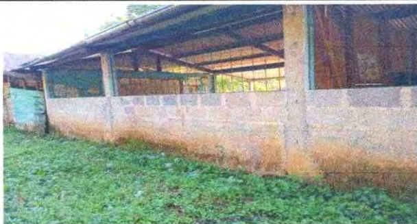
Foto 5: Parte trasera de las aulas 3 y 4 para reforzar columnas y repello blanco de monocapa.
