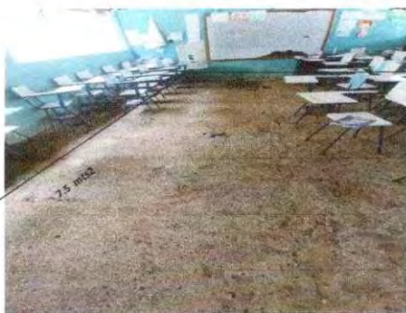
Foto 5: Área frontal específica para situar el piso, Aula 4 con un Total de 45 mts2
